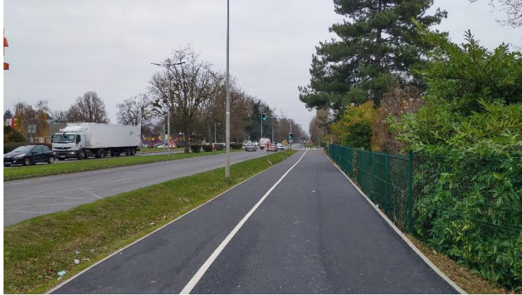
Tronçon de voie douce reliant la rue du Général-de-Gaulle à l'avenue des Peupliers
