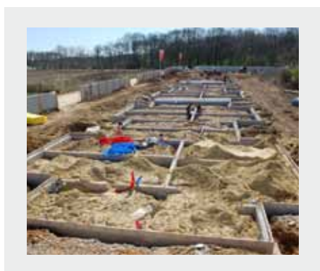
Début des travaux aux Joncs-Marins.
