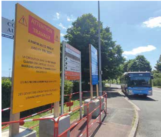
Les travaux ont débuté mi-mai pour une durée de 7 mois.
